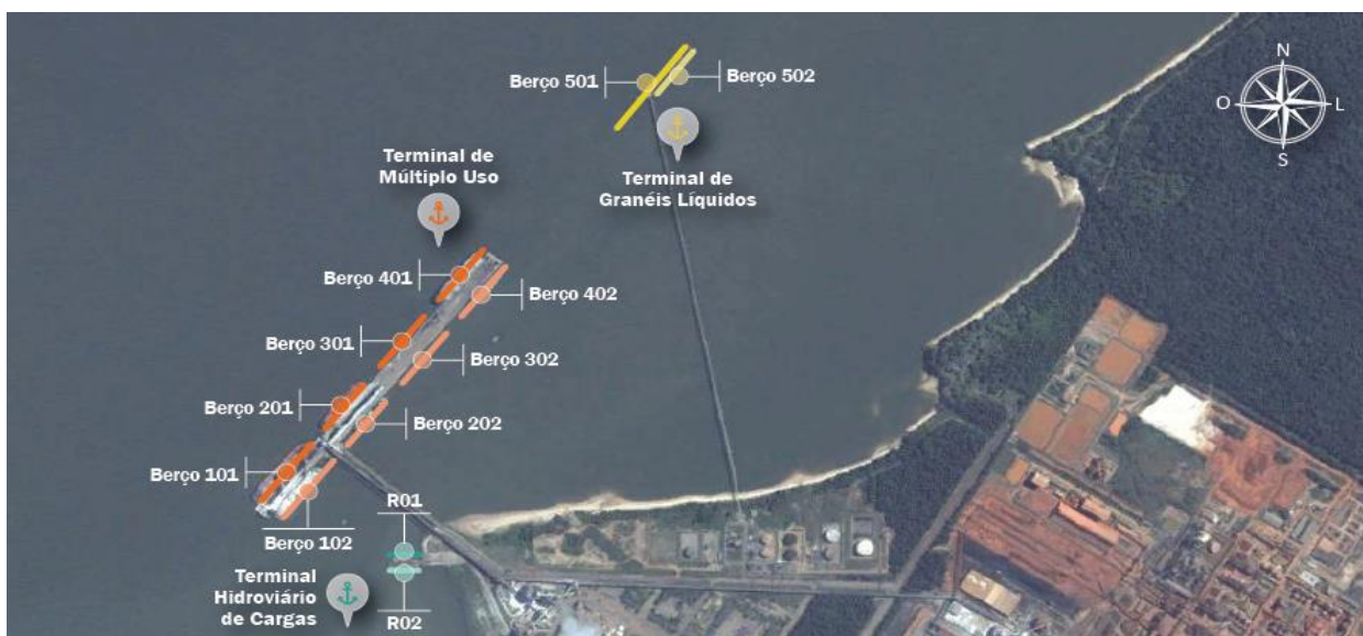
Figura 2: Infraestrutura de acostagem do Porto de Vila de Conde Fonte: Plano Mestre do Complexo Portuário de Belém e Vila do Conde (2017)
